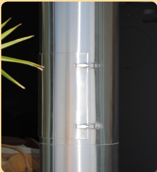
MANTELSTOSS OHNE KLEMMBAND UND DIE PUTZTÜRE OHNE KASTEN
